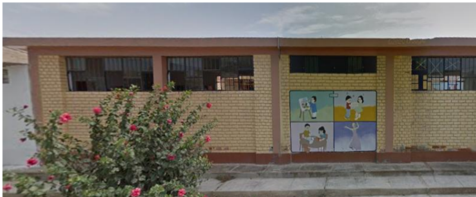
Figura 41 I.E.I N°235 Presencia de columnas cortas en frontis de colegio
