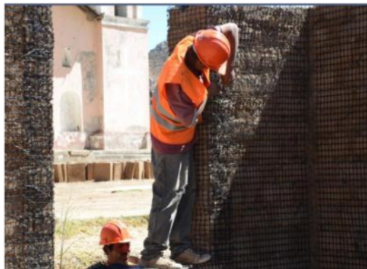
Figura 14 Instalación de geomalla en muros de adobe.
